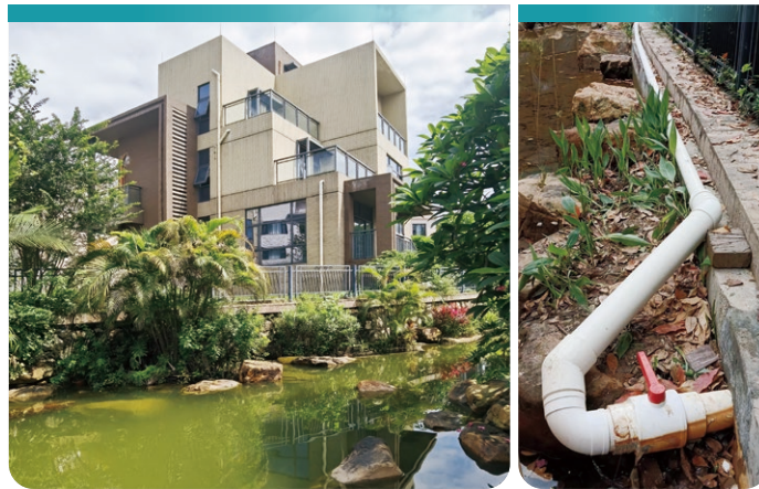
南海雅瑤綠洲「龍灣」及地下水泵和過濾器
